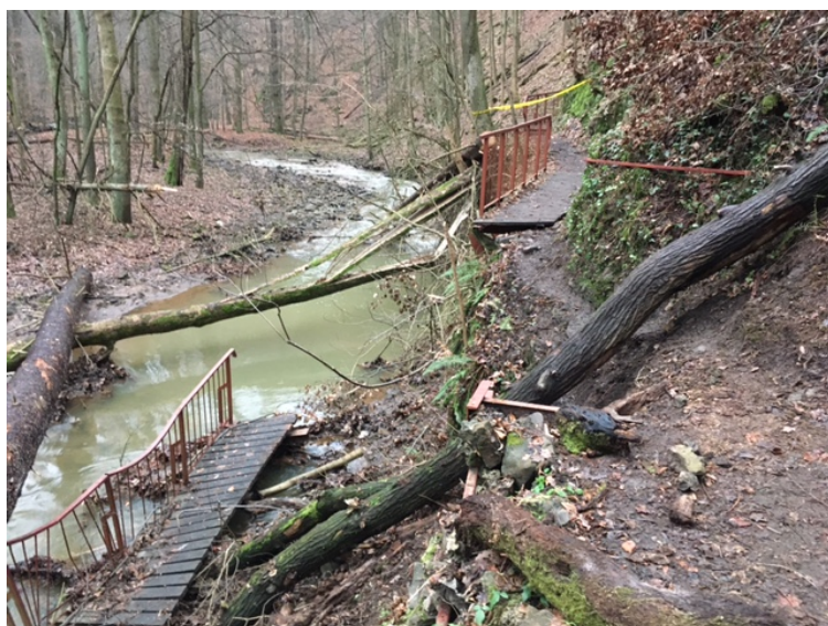
fot. nr 1 - widok ogólny miejsca w którym doszło do zniszczenia kładki.
